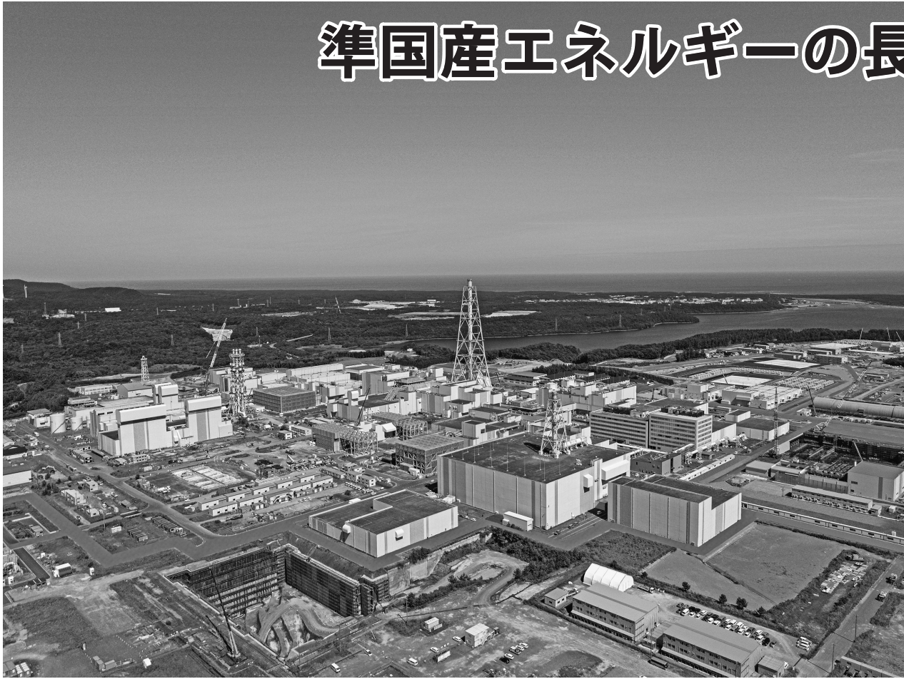
青森県六ヶ所村で建設が進むウラン燃料の再処理工場
